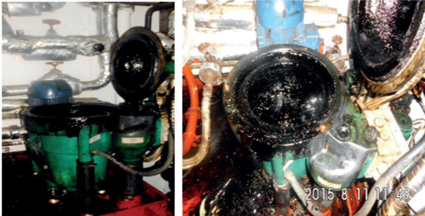
Şekil 1. Yoğun Katı Partikül İçeren Yakıtın Separatör Kirliliğine Etkisi
