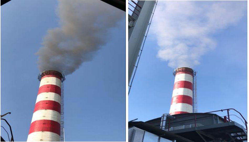
Şekil 2. Geleneksel Yakma (Solda) ve Plazma Yakma (Sağda) Arasındaki Baca Gazında Gözle Görülebilir Fark (Görsel: Soma Termik Santrali)
