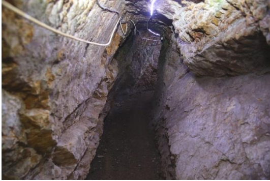
Fotoğraf – 3 (Duvar ve koridor yapısı)
